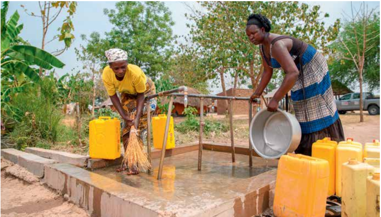
Neben der Wiederaufforstung haben die Malteser die Verantwortung für 15 Brunnensysteme übernommen, sie mit Solarpumpen ausgestattet sowie Leitungen, Tanks und Zapfstellen installiert. Lilian (rechts) zählt zu den 45.000 Menschen, die nun sauberes Trinkwasser erhalten.
