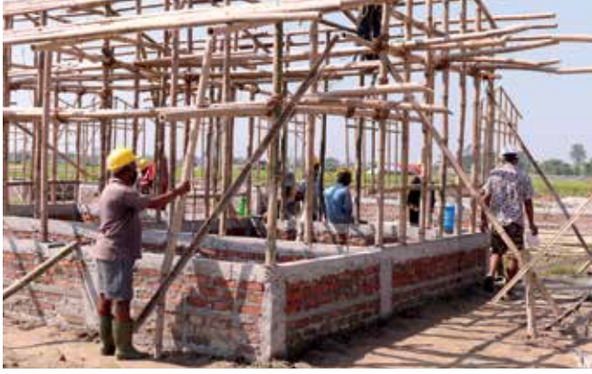
Bambus reduziert die Umweltbelastung beim Hausbau um ganze 75 Prozent.
